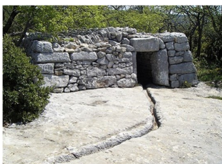
Aiguier et voûte en berceau sur la citerne creusée
