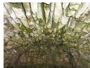
Aiguier et voûte en berceau sur la citerne creusée
